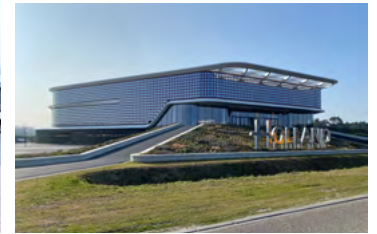
Arch. : Gensler et MSVA Architects.
