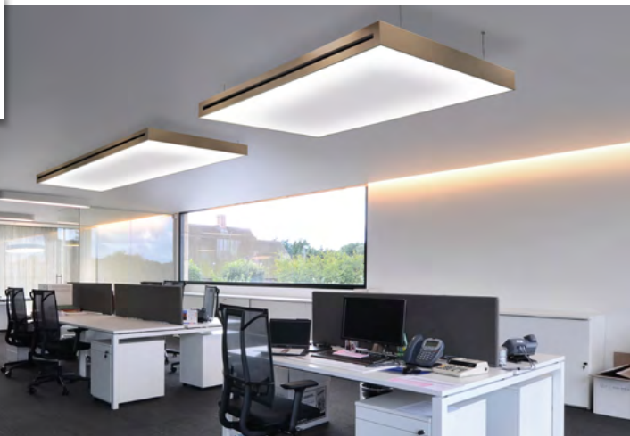
Arch. : Kris Rymenants Architectenbureau bvba
