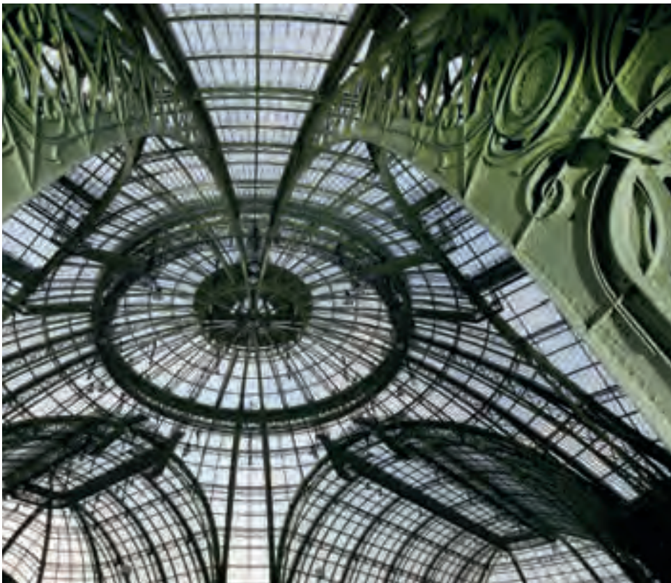
Ref. 12-571624. «La verrière et la structure métallique de la Nef du Grand Palais» - Photographie Gaillarde Raphaël
