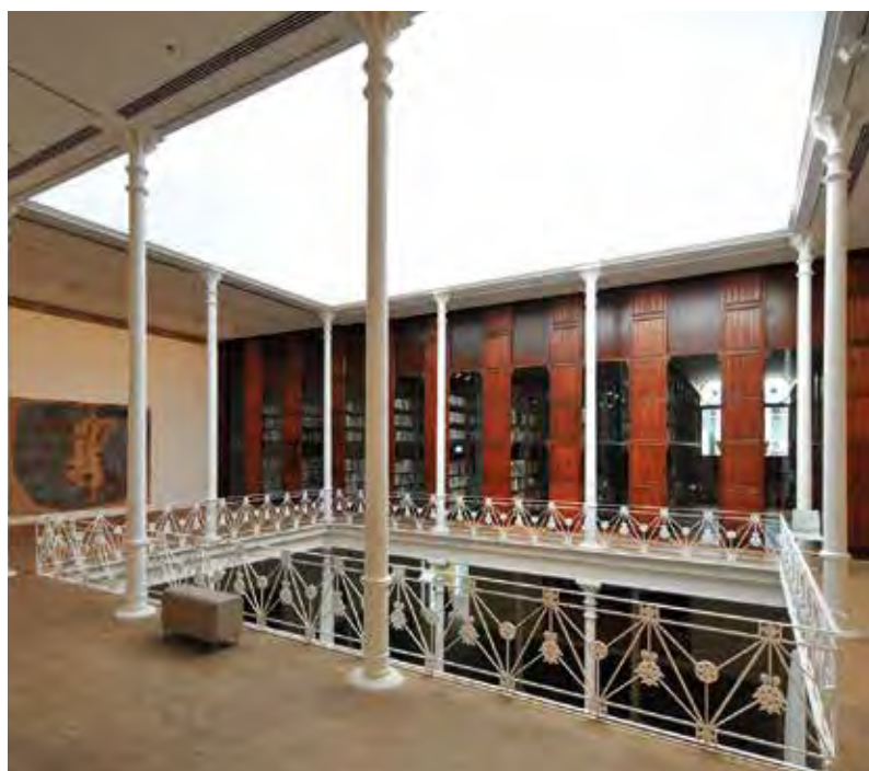
Architecte : Roser Amadó & Lluís Domènech Girbau
