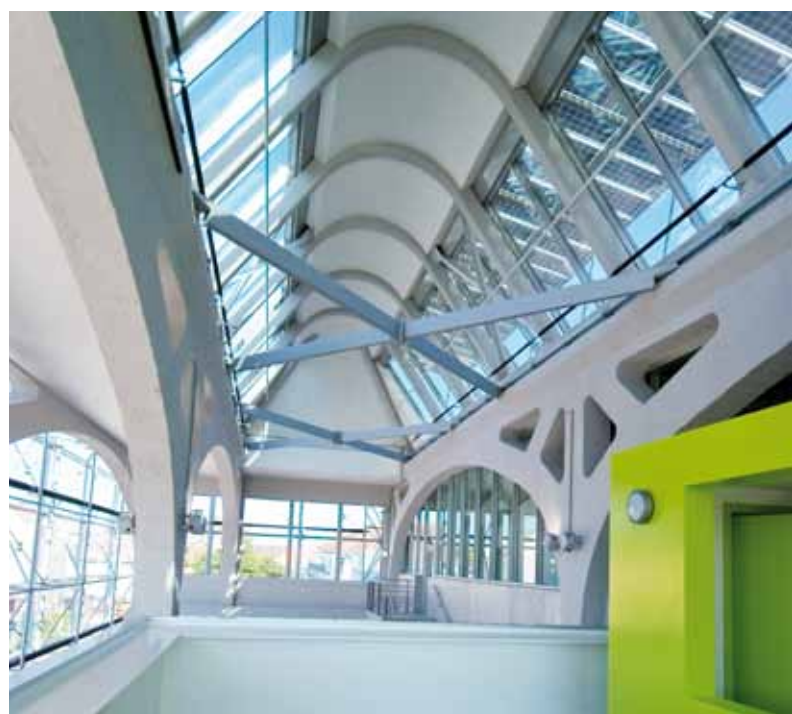
Fonderie de Mulhouse - France - architecte : Christian PLISSON
